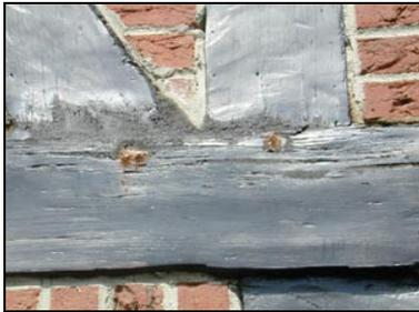
Wo er zu finden ist, braucht man oft kein Messgerät, sondern ein Messer, was sich dann i.d.R. in den Balken einstecken lässt. Regelrecht Spaß macht die Jagd auf Schadensbereiche unsichtbarer holzerstörender Pilze, wenn man die Schleimpilze als Jagdgehilfen versteht.
